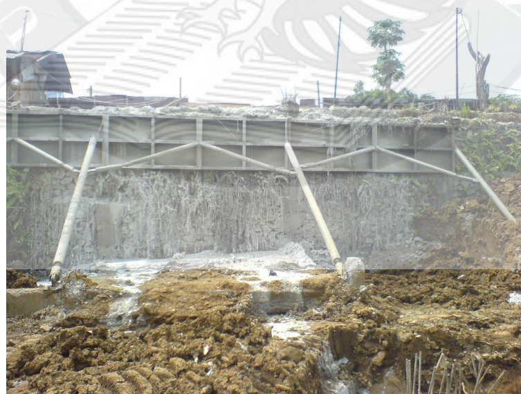
Gambar 1.3. Struktur penahan tanah yang terbuat dari baja
