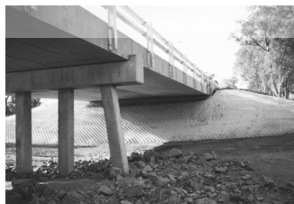
Gambar 1.1. Jembatan menerus (Beton)
