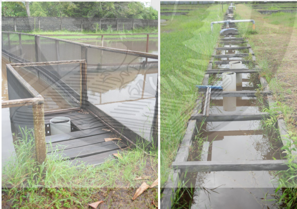
(a) Pemasukan kolam A dari penampungan (b) Parit pemasukan kolam B dan C
