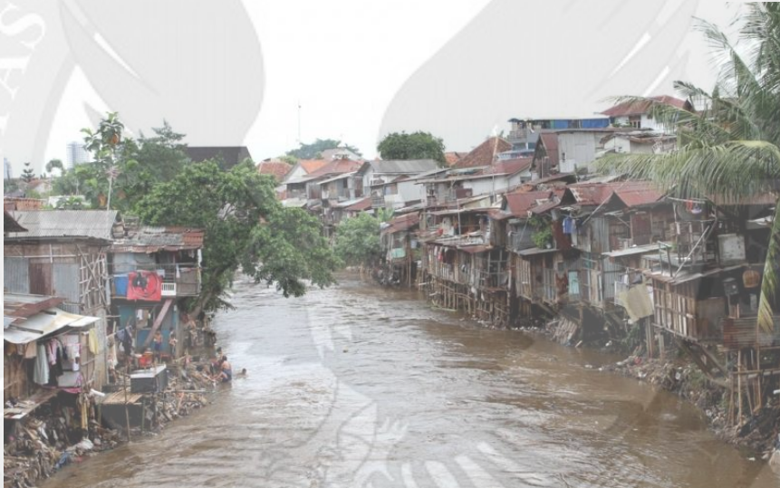
Gambar 1. 1 Kondisi rumah yang dibangun pada bantaran sungai
