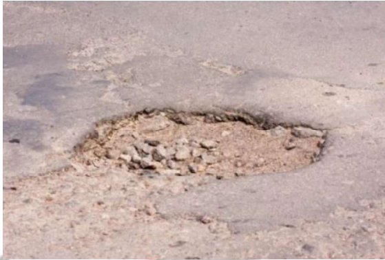
Gambar 1.2. Pengelupasan Aspal
