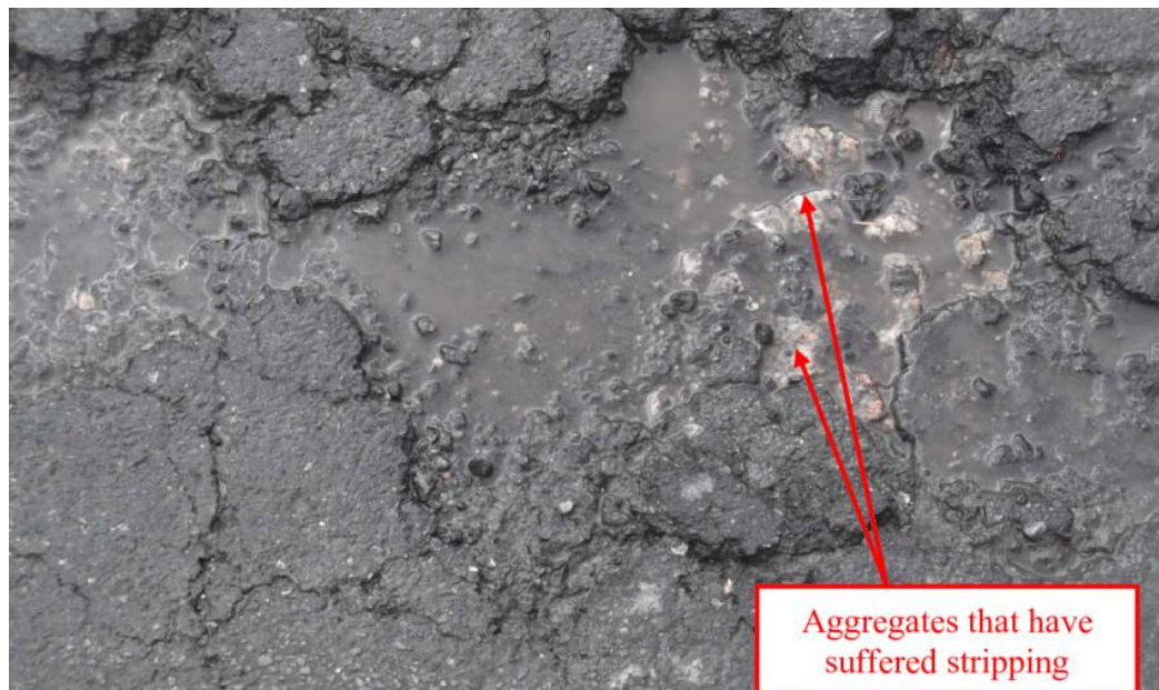
Gambar 1.1. Agregat yang telah mengalami stripping
