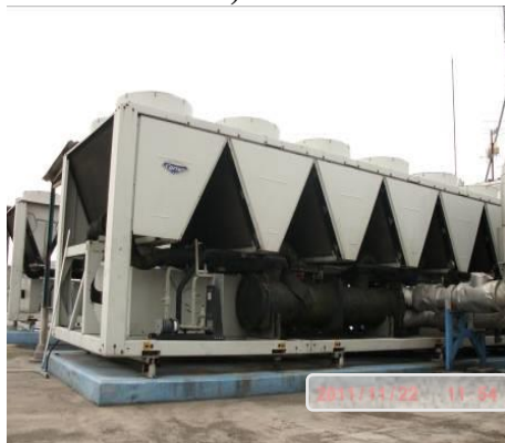
Foto kondisi aktual Chiller milik HMS (Carrier 30GTN)
