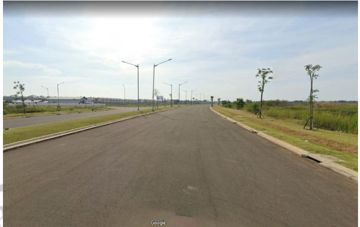
Gambar 4.4 Jalan Primer PIK 2 Loop Sumber: Google Maps
