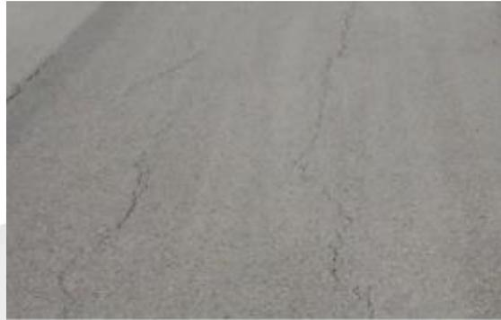
**Gambar 1.1 Kerusakan pada permukaan jalan (retak)**
